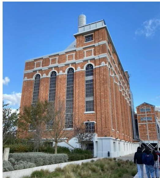
Figura 2 - Edifício da Central Tejo
